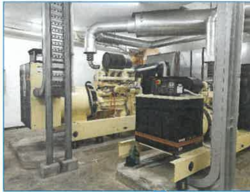
ภาพถ่ายที่ 2.2-13 เครื่องสำรองไฟฟ้า
